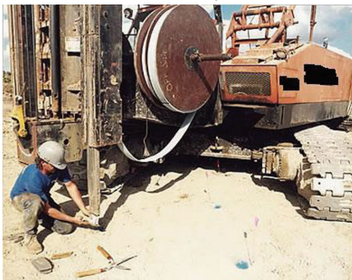
Σχ. 3 - Εξοπλισμός τοποθέτησης κατακόρυφων στραγγιστηρίων.
