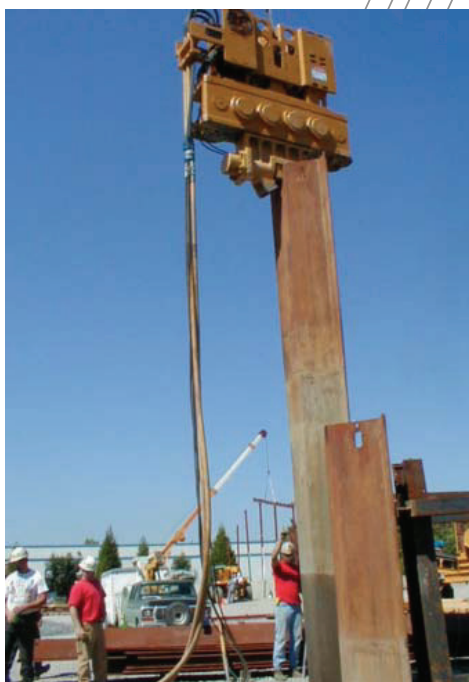
Σχήμα 3 - Εξόλκευση τμήματος πασσαλοσανίδας με την χρήση δονητικού πασσαλοπήκτη/ εξολκέα και γερανού
