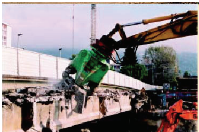
Σχήμα 3 - Καθαίρεση φορέα οπλισμένου σκυροδέματος με υδραυλική σιαγώνα βαρέως τύπου
