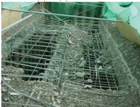
Σχήμα 1. Αποσύνθεση πλάκας οπλισμένου σκυροδέματος με υδροκοπή (hydrodemolition) με ταυτόχρονη αποκάλυψη του οπλισμού
