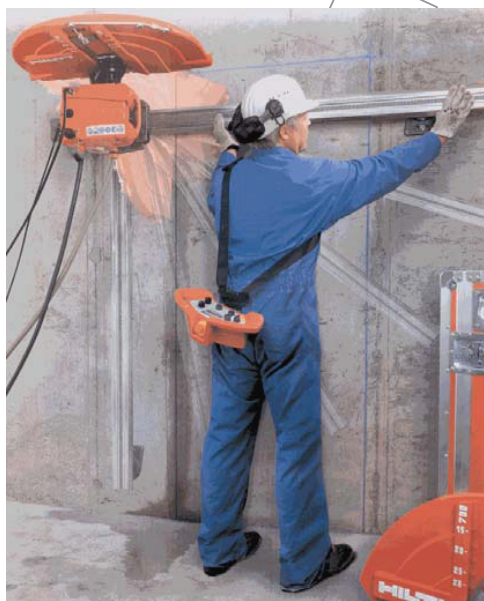
Σχήμα 2 - Κοπή τοίχου με δισκοπρίονο επί τροχιών καθοδήγησης
